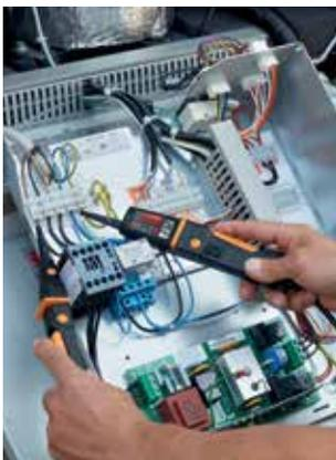
Spannungsmessung an einem Verdichter.
