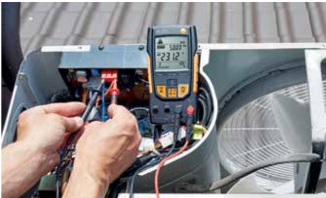
Spannungsmessung an einer Kälte-Außeneinheit mit **testo 760**.
