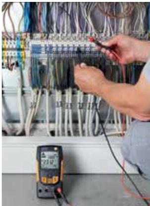
Spannungsprüfung am Schalt-schrank.
