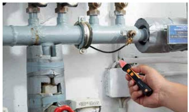
Spannungsüberprüfung an einer Verteilerdose mit **testo 745**.
