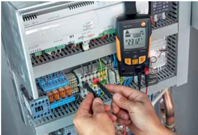
Spannungsprüfung am Schaltfeld einer Wärmepumpe.
