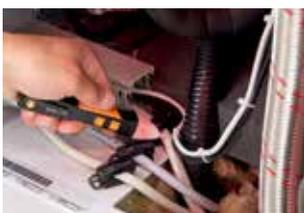
Erstprüfung der Spannungsversorgung an einem Verdichter.
