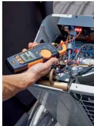
Einfädeln der Stromzange an einer Kälte-Außeneinheit.
