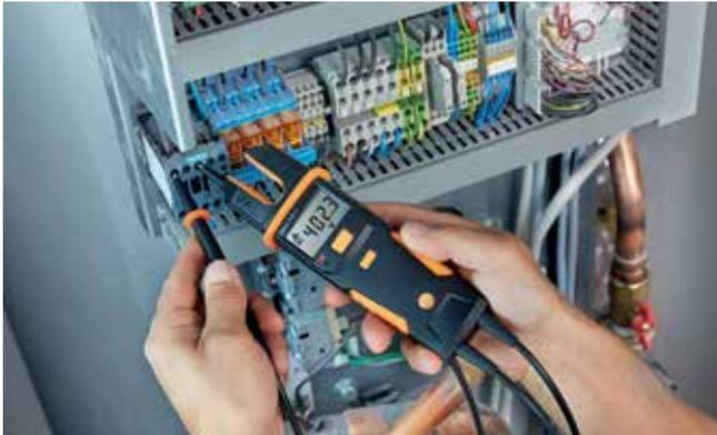
Spannungsprüfung an einer Wärmepumpe mit **testo 755**.
