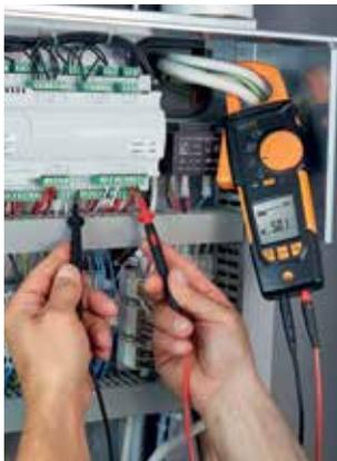
Spannungsmessung am Schaltfeld einer Wärmepumpe mit aufgehängtem Messgerät.
