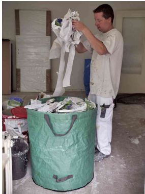
Anwendung bei Renovierungsarbeiten
