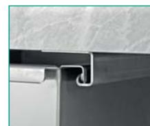
Aufhängung oben an Führungsschienen (an der Waschtischunterseite)
