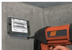
Montageplatte mit montierter WINSTA®-Verteilerbox an der Wand befestigen (z.B. mit Bolzenschubgerät).
