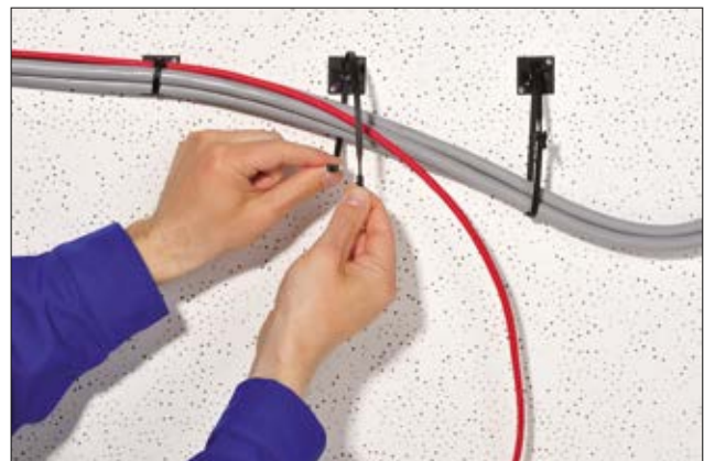
Q-ties, zonder extra inspanning of voorzieningen te gebruiken voor zowel tijdelijke als permanente bundelingen.
