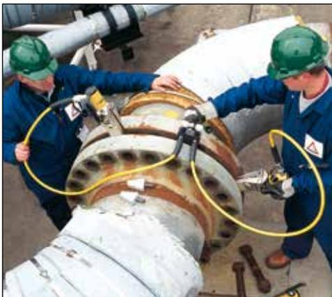
◀ Zwei FSH-14 Spreizer im Einsatz mit Enerpac Handpumpe, Schläuchen und AM-21 Doppelabsperrventile.
