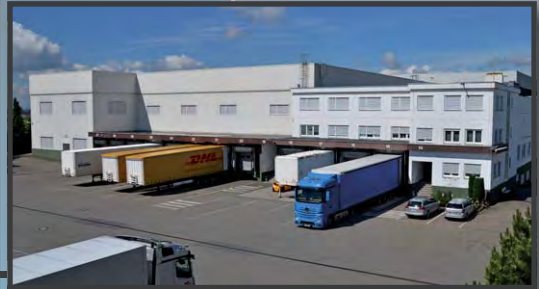
Hugo Brennenstuhl GmbH & Co. KG Headquarter Werk 2
