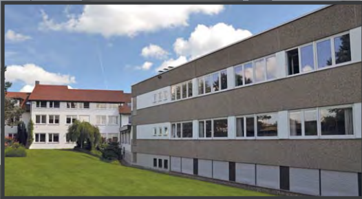
Hugo Brennenstuhl GmbH & Co. KG Headquarter Werk 1
