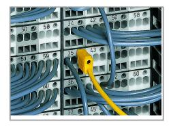
Prüfen mit Prüfstecker (210-137) Ø 2,3 mm
