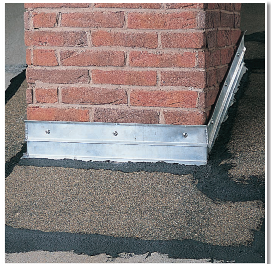
Kappeleiste am Schornstein mit SCHWARZER BLOCKER SPACHELMASSE und Bitumenbahn abgedichtet.
