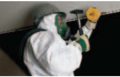
Abriss- und Montagearbeiten
